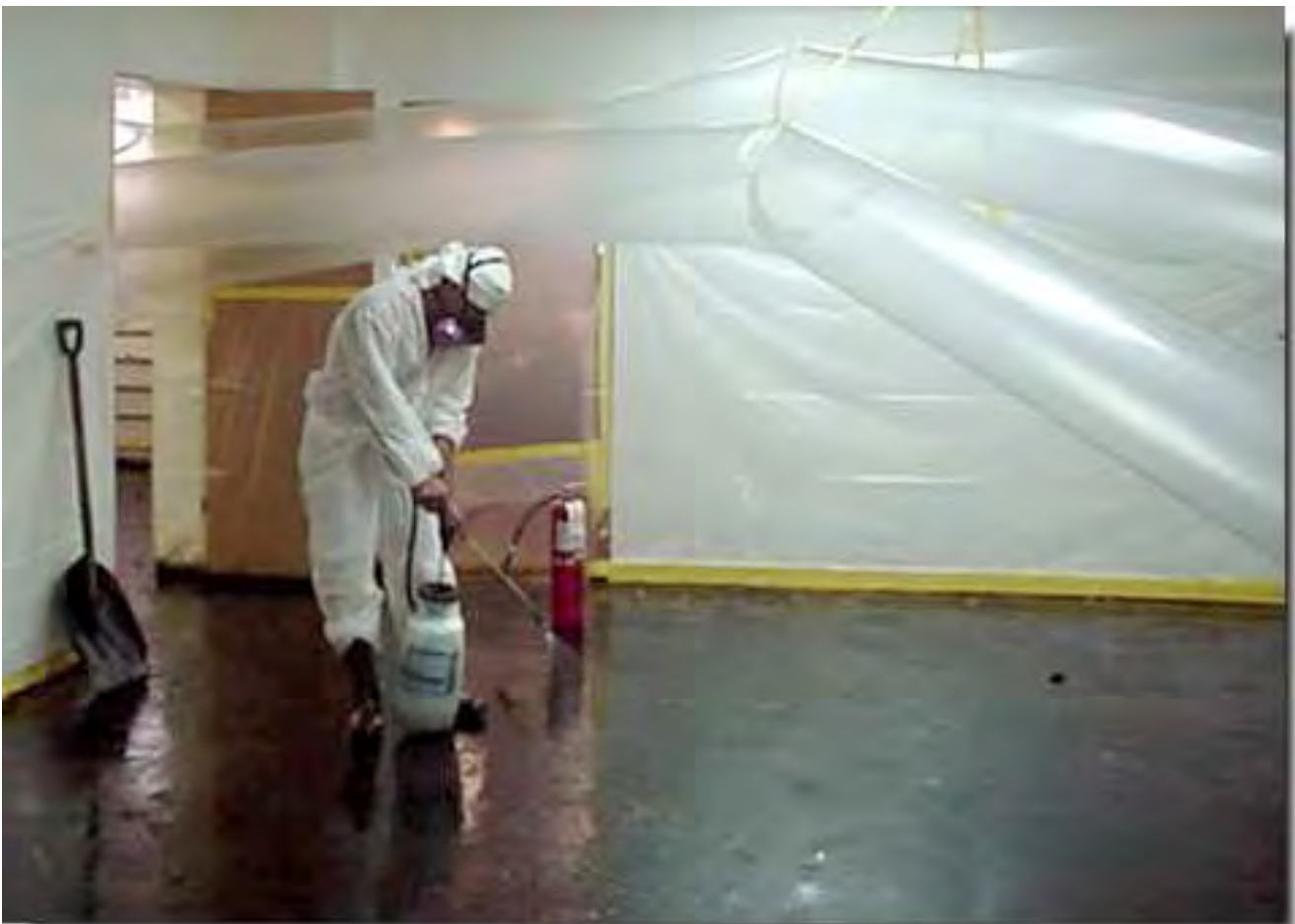
Figura 20 - Confinamento statico e dinamico
