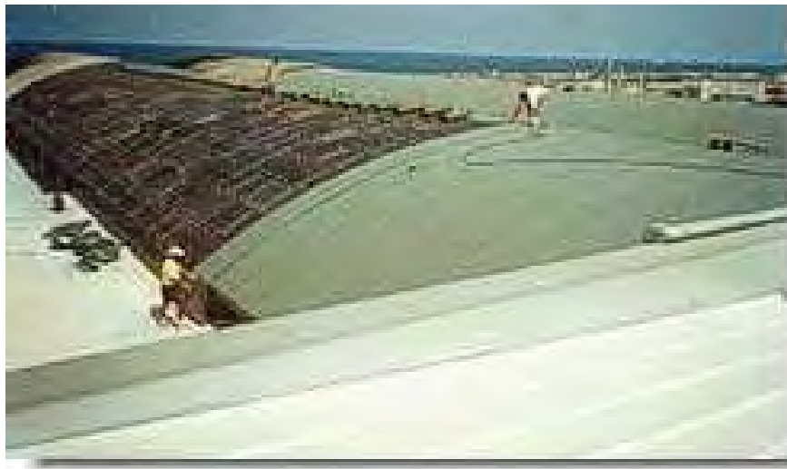
Figura 17 - Rivestimento di una copertura
