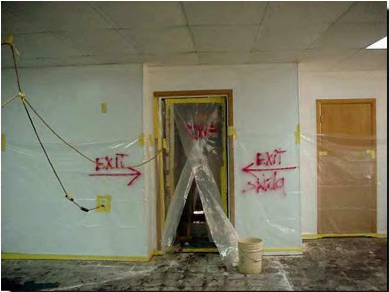
Figura 28 - Delimitazione dell'area di lavoro: uscita
