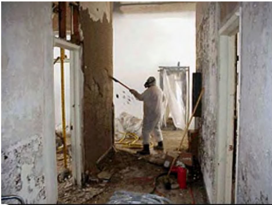
Figura 26 - Rimozione rivestimento dopo il trattamento
