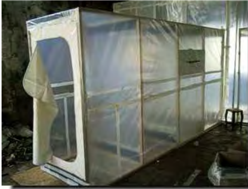
Figura 24 - Decontaminazione dei rifiuti e/o attrezzature
