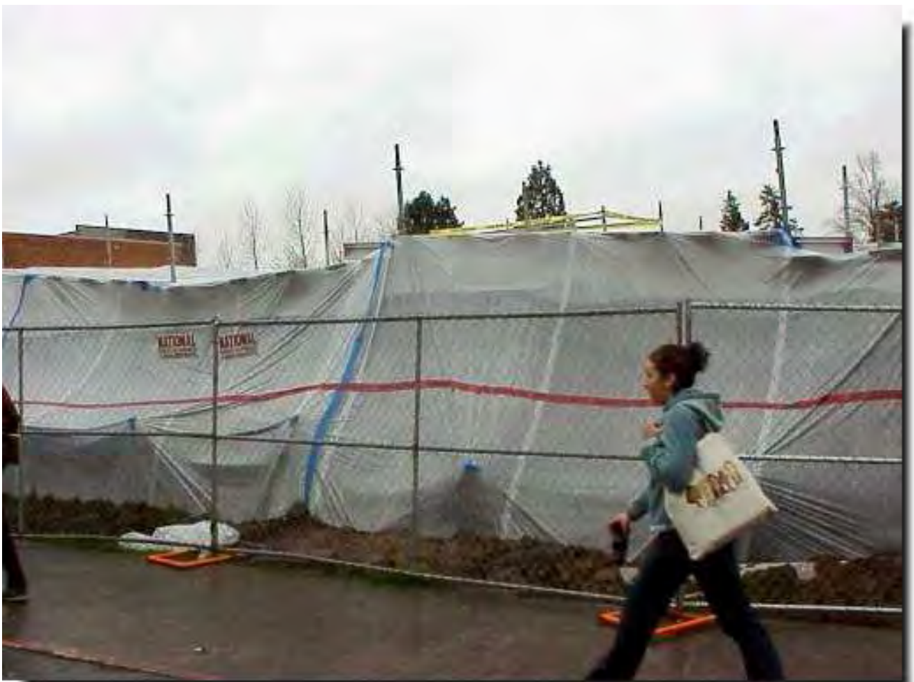
Figura 19 - Cantiere di lavoro
